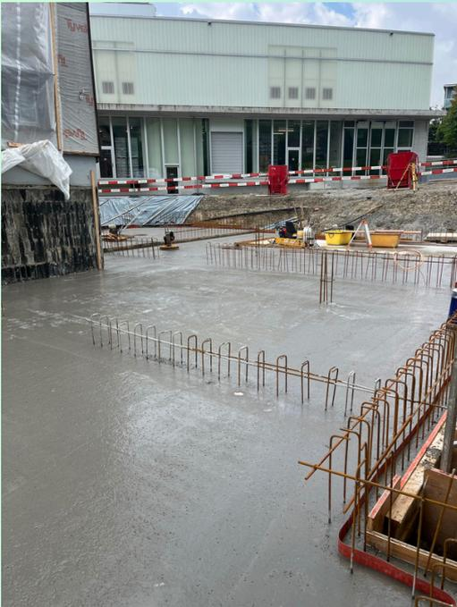
**5 Tage später ist bereits die Bodenplatte betoniert.**
