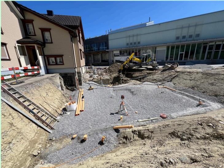
**26. Juni 2025 Der Aushub hinter dem Haus ist abgeschlossen. Das Eternit wurde bereits von der Fassade entfernt.**
